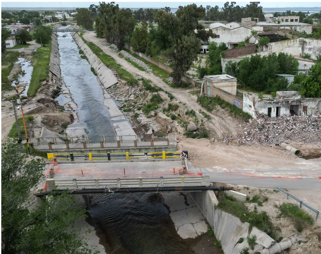
Construcción de puente vehicular Pampa Central. En ejecución.
